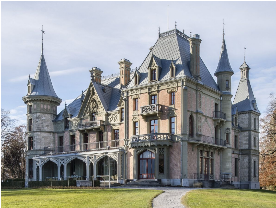
Das Schloss Schadau in Thun nach der Instandsetzung von Suter + Partner Architekten Bild: Christian Helme
