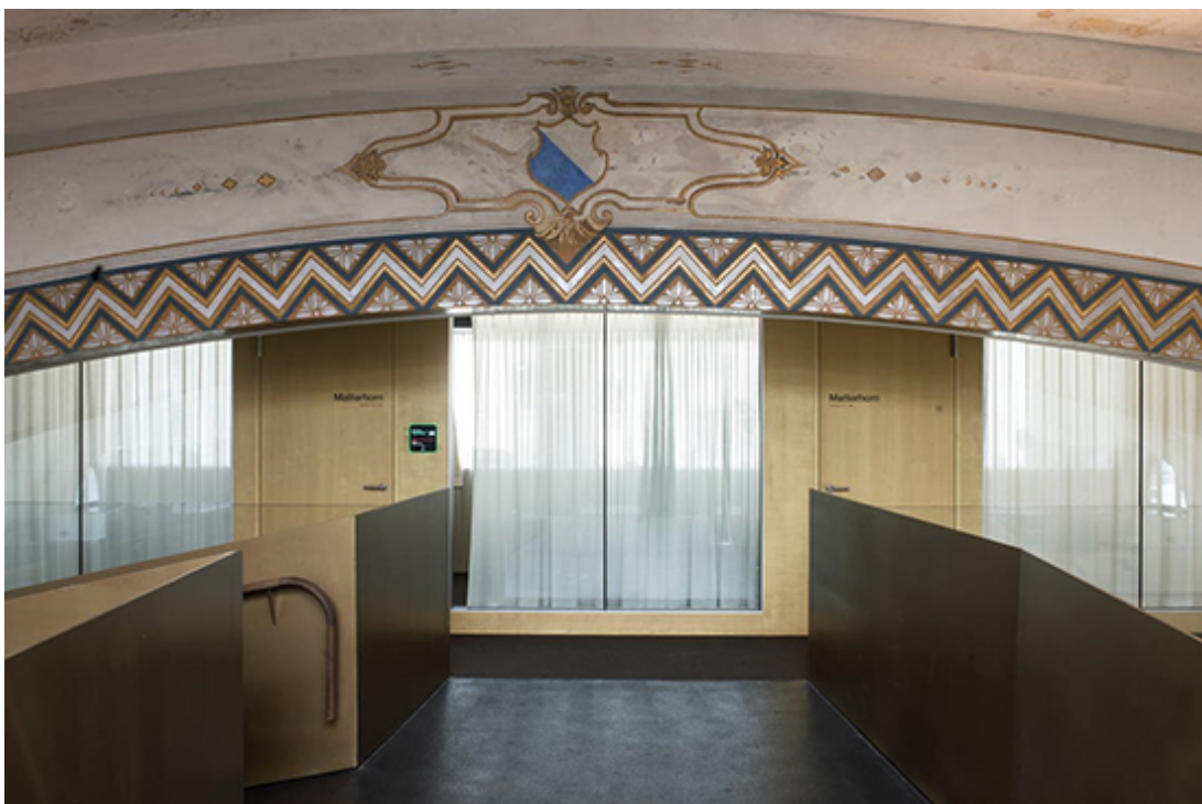
Renovation der Bühnenumrandung, Stadthalle Zürich (Hauptsitz Schweiz Tourismus), 2019
