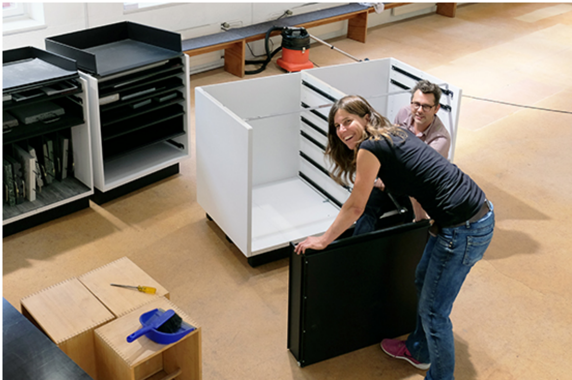
Umbauarbeiten in der SBCZ, August 2017
