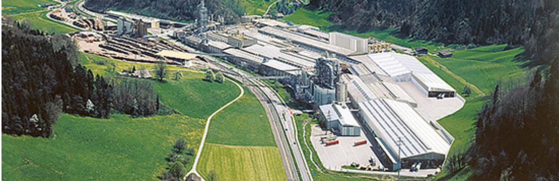
Das Swiss Krono Spanplattenwerk in Menznau, LU
